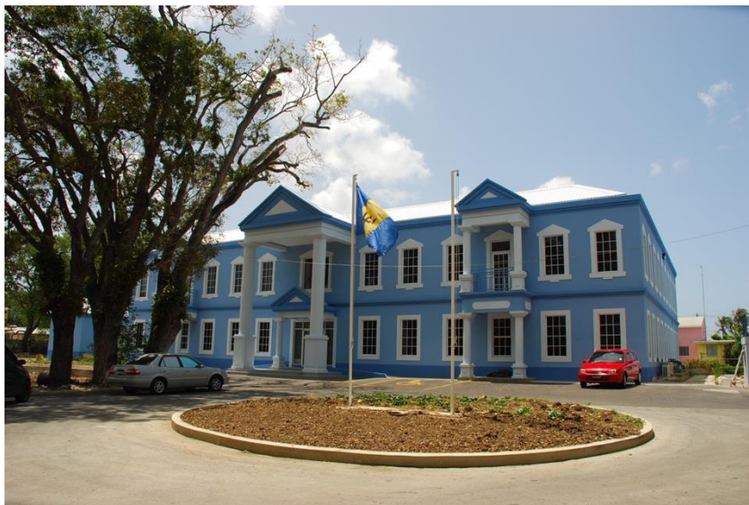
中建承包项目——工会新办公楼
