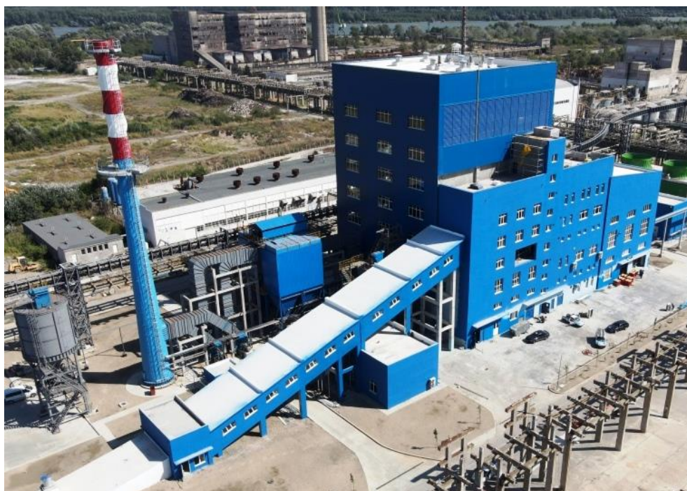
济南锅炉承建的保加利亚斯维洛萨（SVILOSA）公司生物质废弃物发电厂项目
