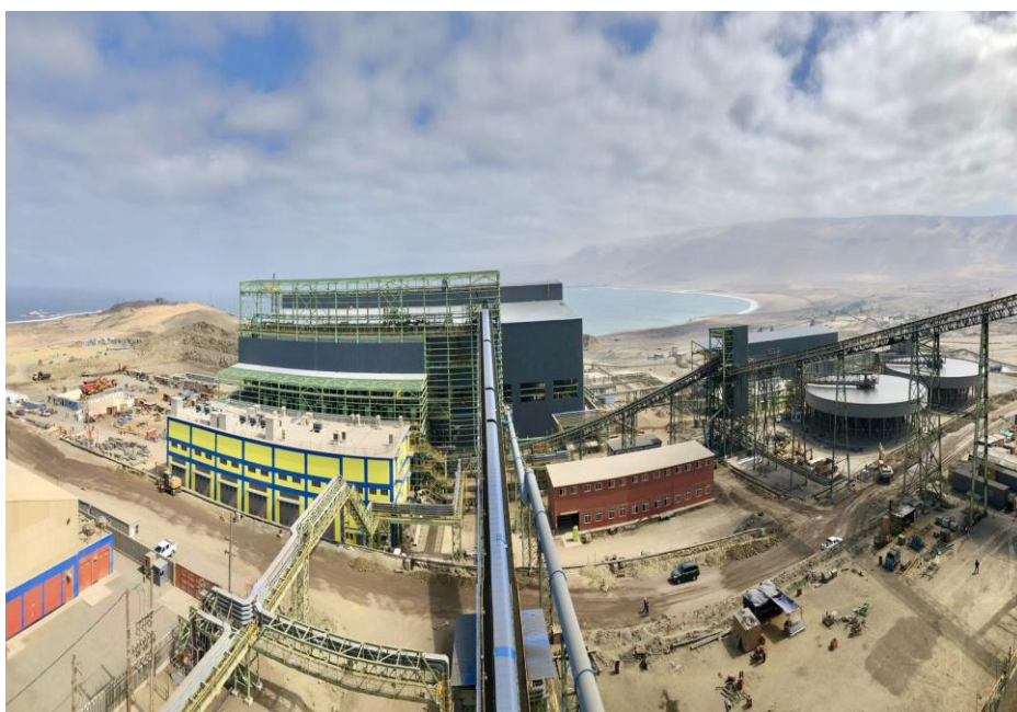
首钢秘铁二期扩建工程投入使用
