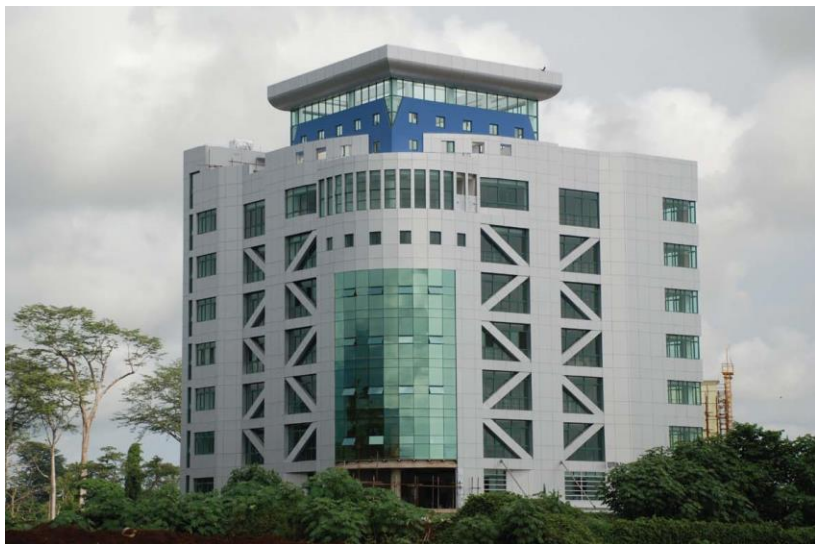
赤道几内亚总理府办公楼
