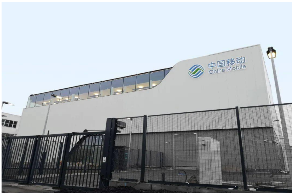
中国移动国际有限公司德国数据中心
