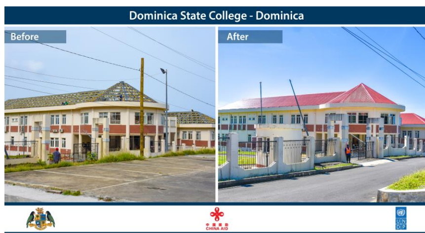
多米尼克国立大学屋顶修复项目实施前后
