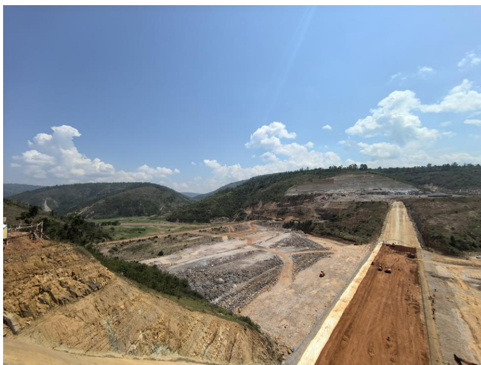
中国电建那巴龙格河水电站二期项目施工
