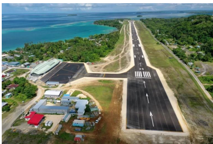
中国港湾公司承建的所罗门群岛蒙达机场跑道升级项目
