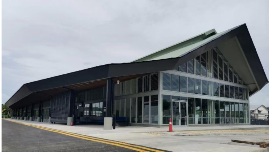
中国土木公司承建的蒙达机场航站楼项目
