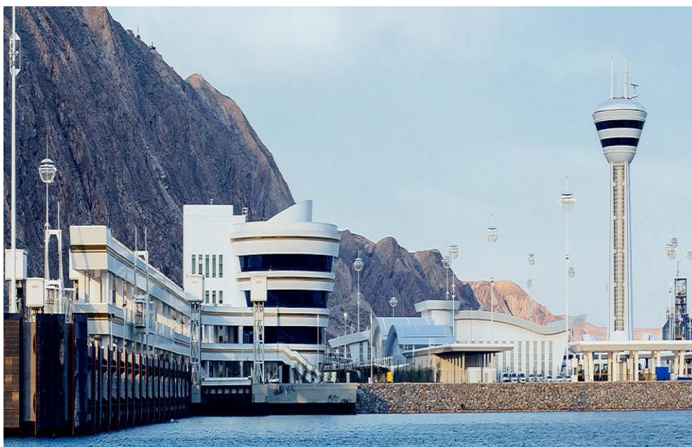
土库曼巴什新国际港口
