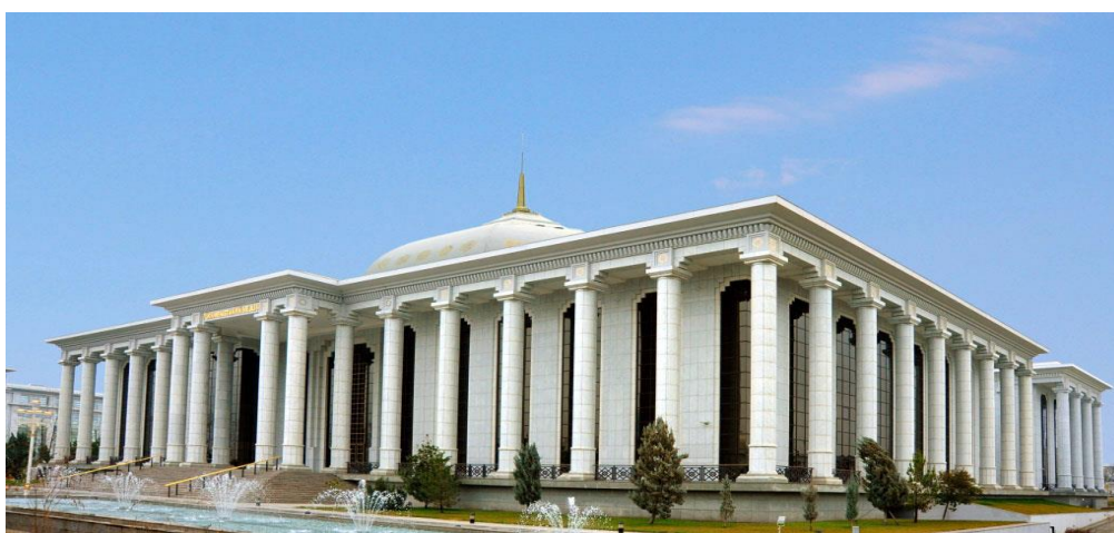
土库曼斯坦议会大楼
