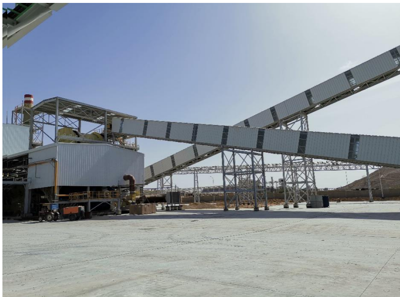
东华科技承建突尼斯化工集团项目
