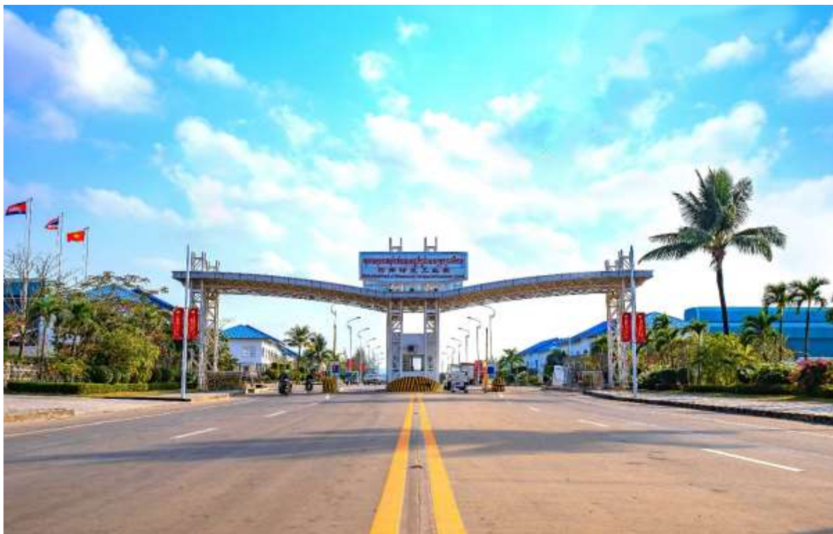
柬埔寨西哈努克港经济特区工业厂区
