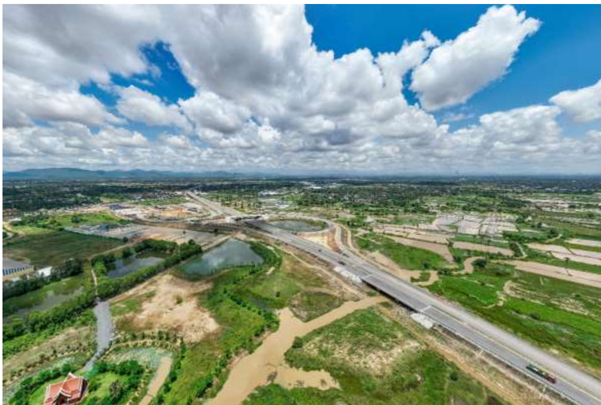
金港高速公路
