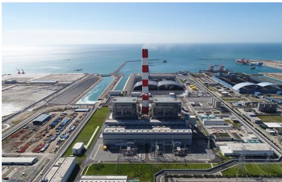
永新一期燃煤电厂
